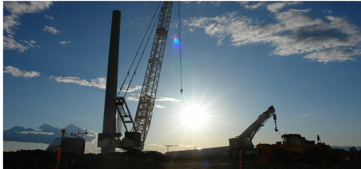
Grans grues ajuden a aixecar la torre d'un aerogenerador a les obres de construcció del parc eòlic Alta Anoia, al municipi de Pujalt.
