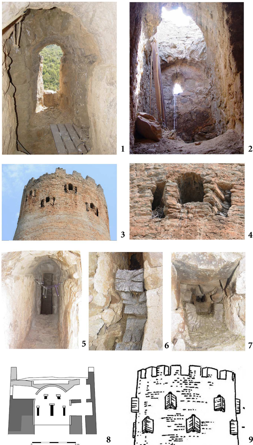
Fig. 11. 1. Final de l'escala intramural amb cambra amb obertura de lladronera; 2. cambra superior posteriorment aprofitada per a pas a la terrassa; 3. acabament superior amb lladroneres o cadafals; 4. detall d'un dels cadafals o lladroneres des de l'exterior (J. A. Adell); 5. detall de l'interior d'un dels cadafals o lladroneres des de l'exterior de la torre (J. Olivé); 6. detall de la fusta dels costats de lladronera o cadafal (J. Olivé); 7. desguàs de la zona superior de la torre, relacionable amb la hipotètica segona latrina proposada per Cabañero; 8. secció de la cambra de combat (base J. Aguirre Estop amb modificacions); 9. proposta de restitució de la zona superior de la torre segons X. Hernández (2003)
