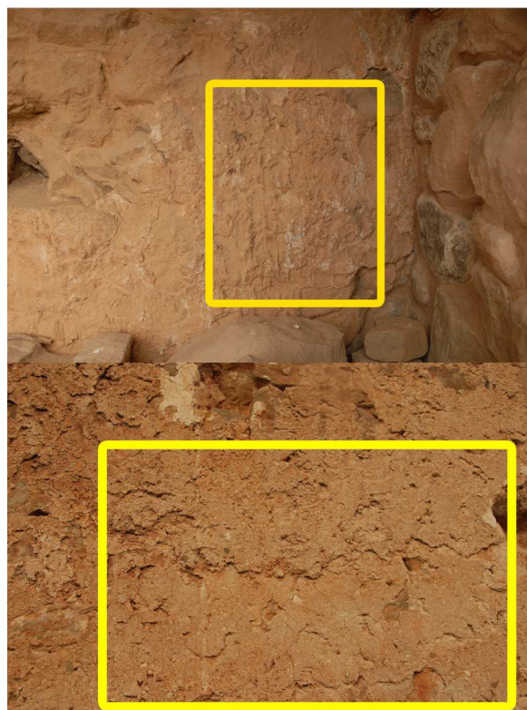
Fig. 5. Detall de l'acabat de l'anella interior amb marca de regalims de morter, i de l'exterior amb solapament de capes
