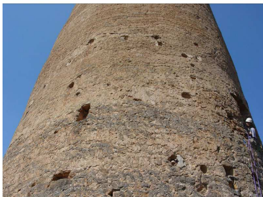
Fig. 14. 1. Escala interior; 2. merlets de la terrassa; 3. encaixos de bigues a l'exterior de la torre; 4. petit dipòsit o encaix al peu de la torre
