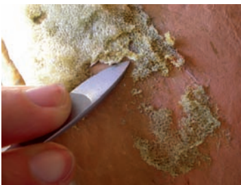
Eliminació mecànica de les espumes protectores desgastades
